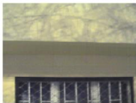
8. Detail tepelného mostu - nekorrektně zatěsněný odtokový kanálek terasy (terasa následně zasklena a připojena k obývacímu pokoji).
